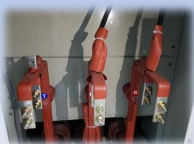
应用在检测配电盘三相电源螺丝固定不良或松脱造成温度异常的无线检测系统，传感器具备无线传输与无线电源特性
